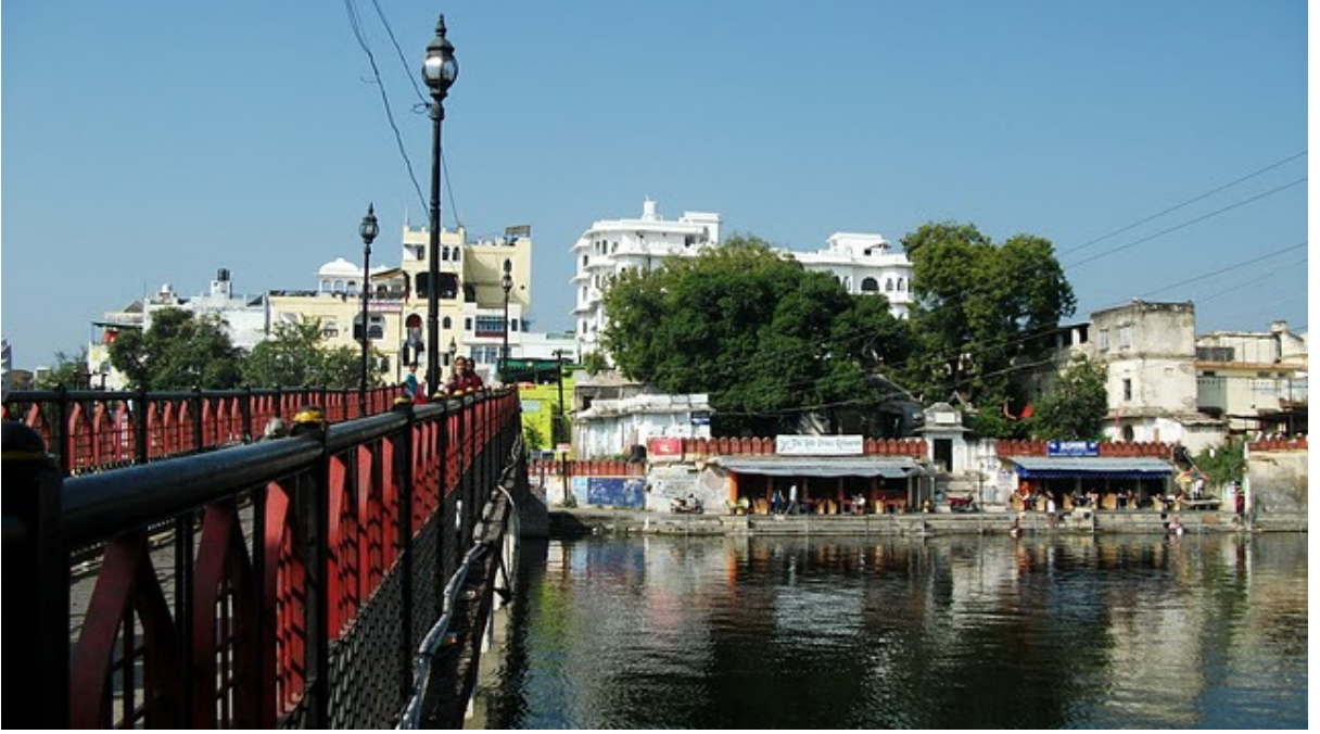
Chandpole Bridge'den bir görüntü
